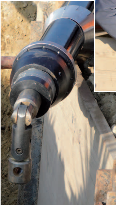
Montage du dynamomètre
