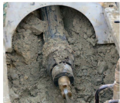
Arrivée dans la fosse de tirage
