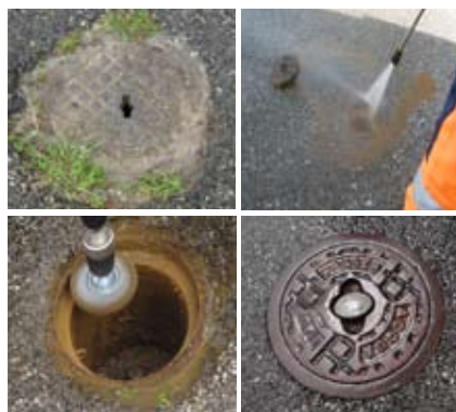
Apertura e pulizia della cappa stradale
