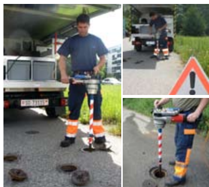
Azionamento meccanico della saracinesca
