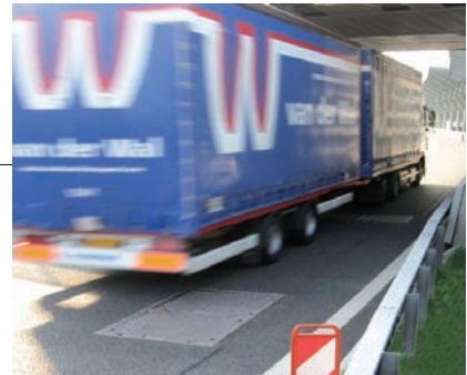
ROLLMATIC Fig. 2535 „autoroute“ Autoroute A2 Chiasso-Brogeda voies de circulation pour poids lourds
