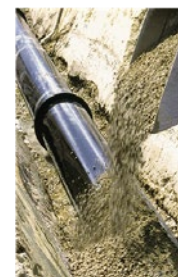
Facilité de pose
