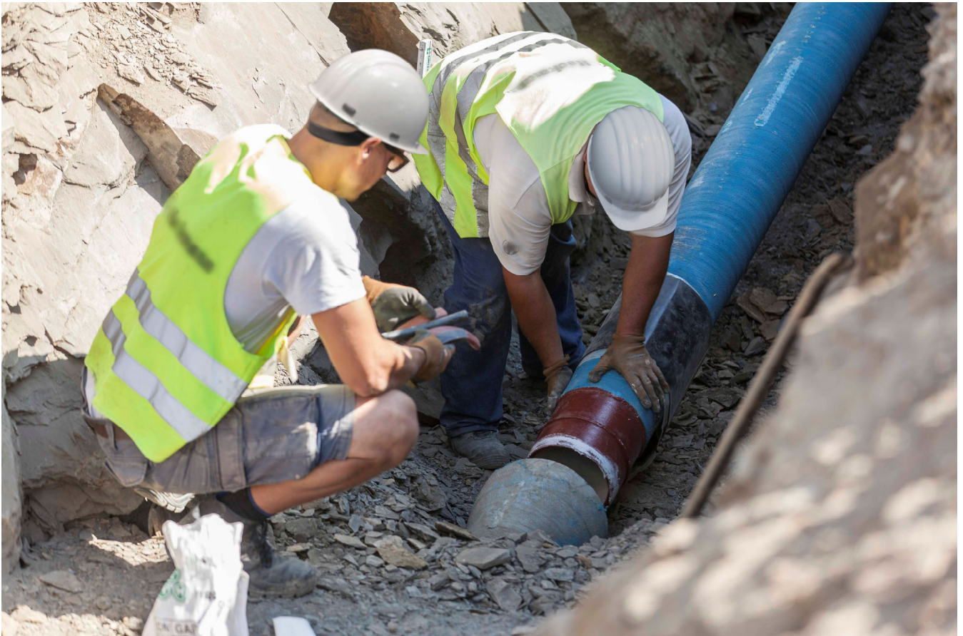
Tendido de tubos/montaje en zanja abierta
