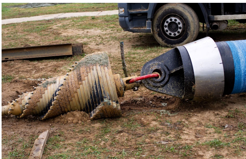
Collegamento fra testa di espansione e testa di trazione del tubo DN 600
