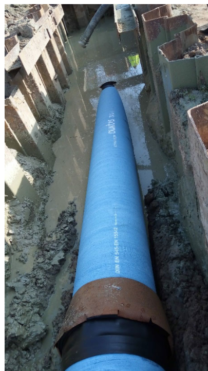
Verifica funzionale della testa di perforazione prima dell'introduzione del tubo – Introduzione del tubo nel foro di perforazione
