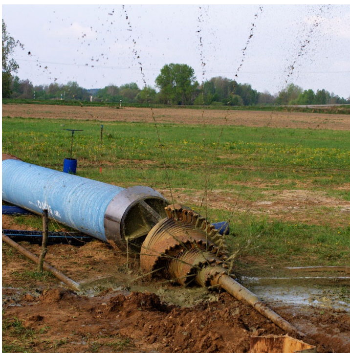
Verifica funzionale della testa di perforazione prima dell'introduzione del tubo – Introduzione del tubo nel foro di perforazione
