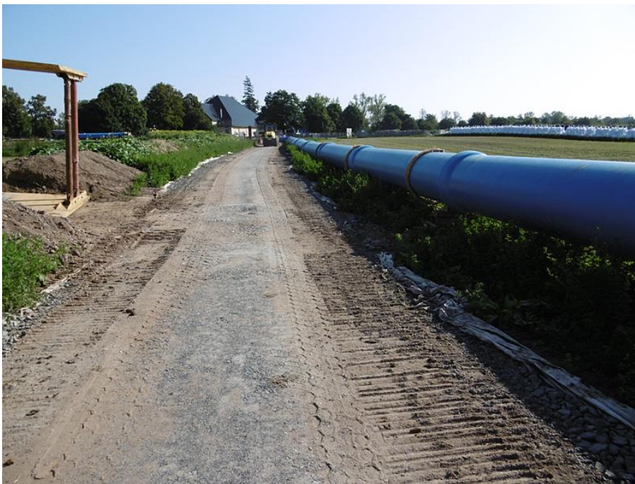
Percorso rettilineo della condotta provvisoria lungo la strada di cantiere verso l'impianto di filtrazione di Canitz
